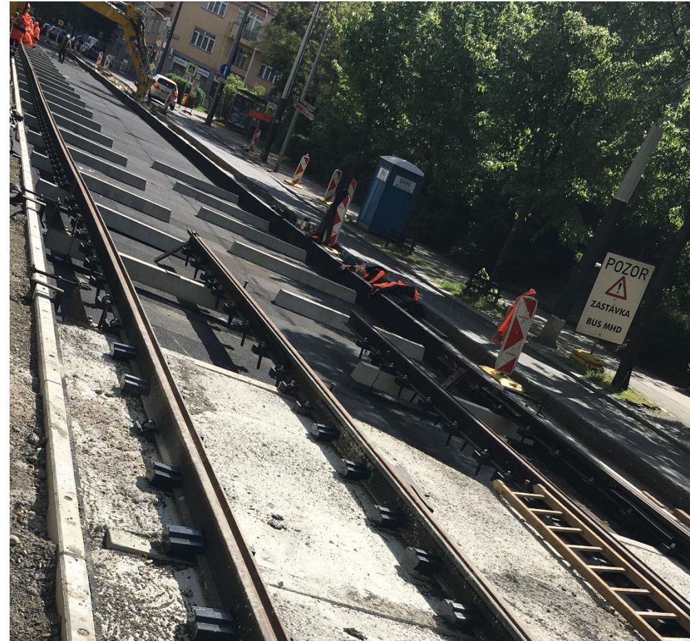
Устройство трамвайного пути закрытого типа для совмещенного движения с защитой рельсовых скреплений пластиковыми крышками в районе исторической застройки.
